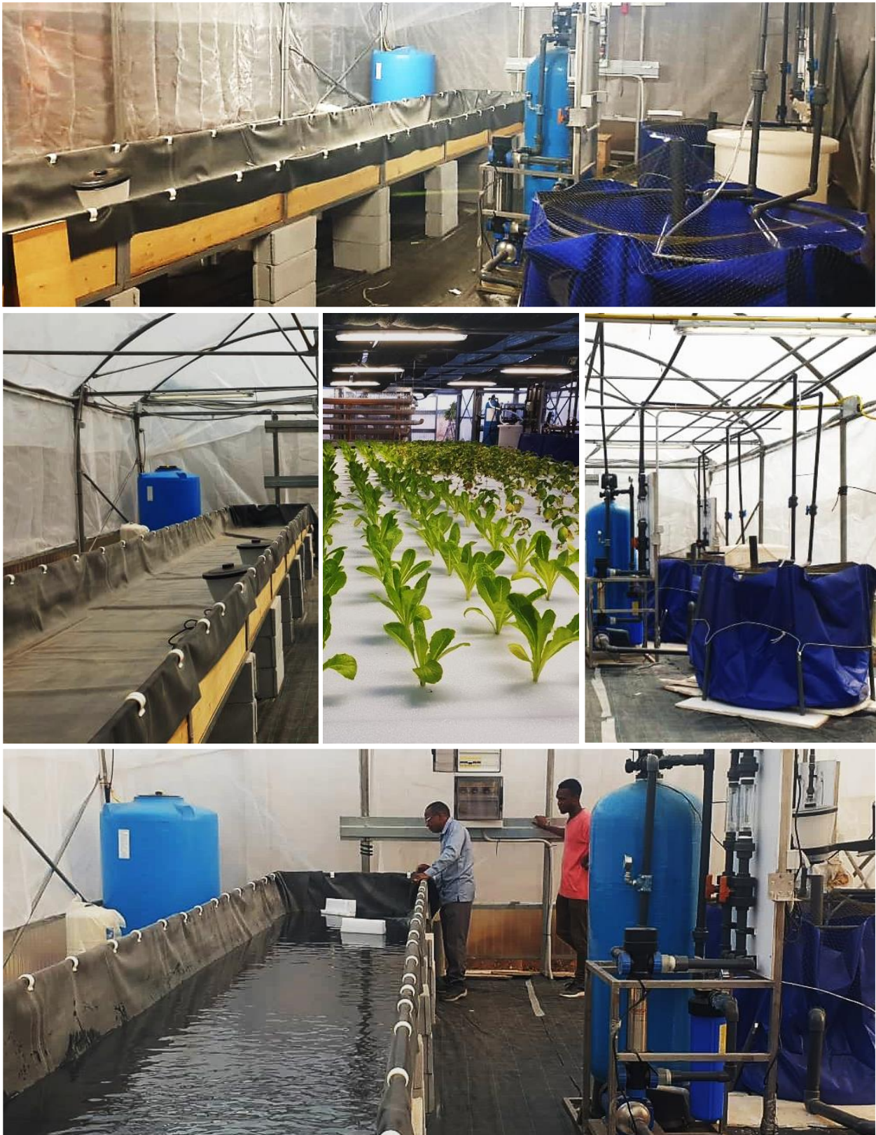
Dettaglio dell'impianto acquaponico e avvio.
