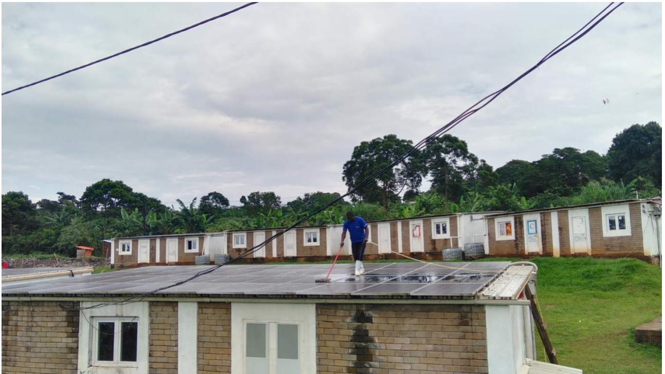
Immagine 8 -Tecnico AE durante la pulizia ordinaria dei moduli fotovoltaici.
