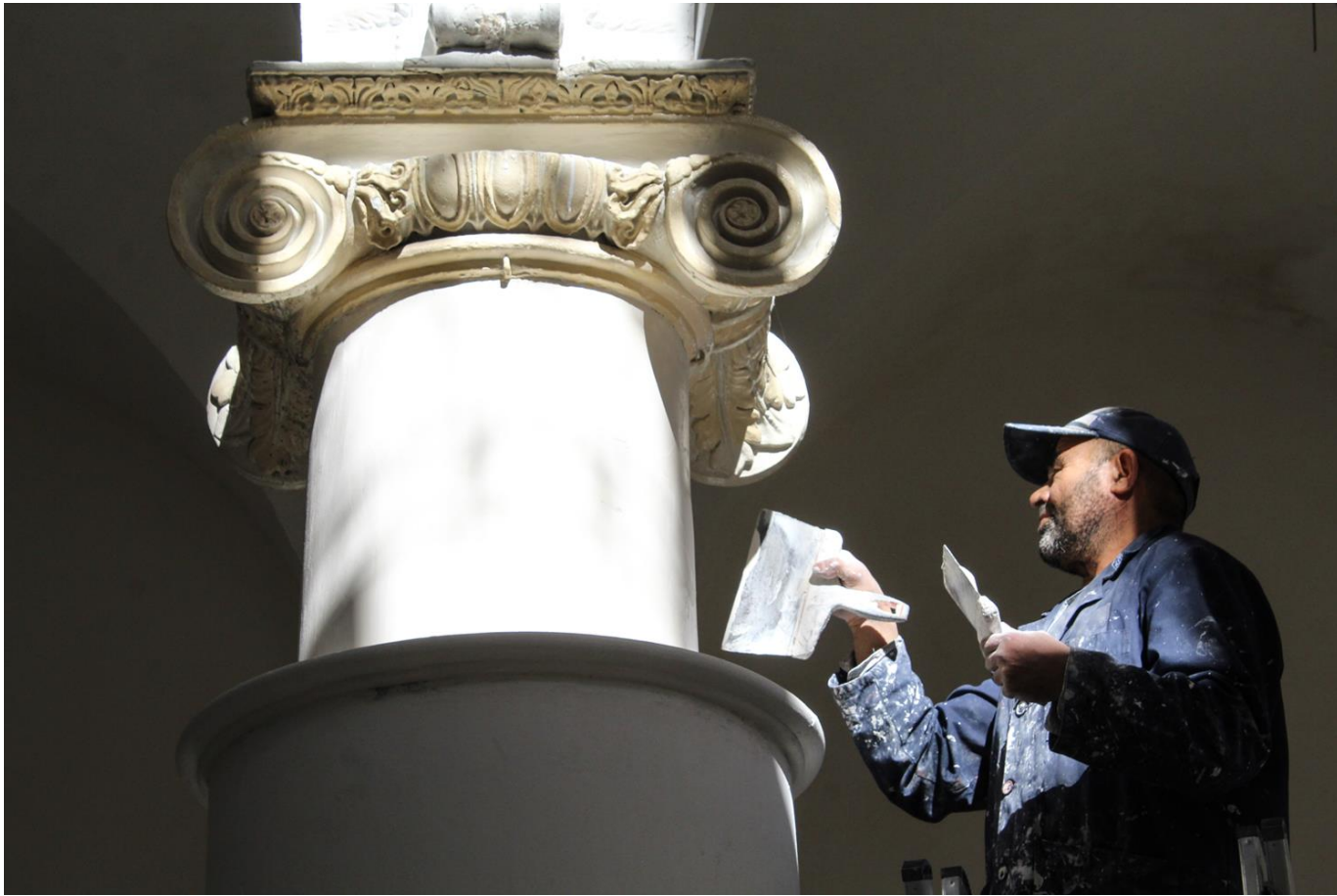
Ouvrier au travail lors de la restauration d'une colonne d'église
