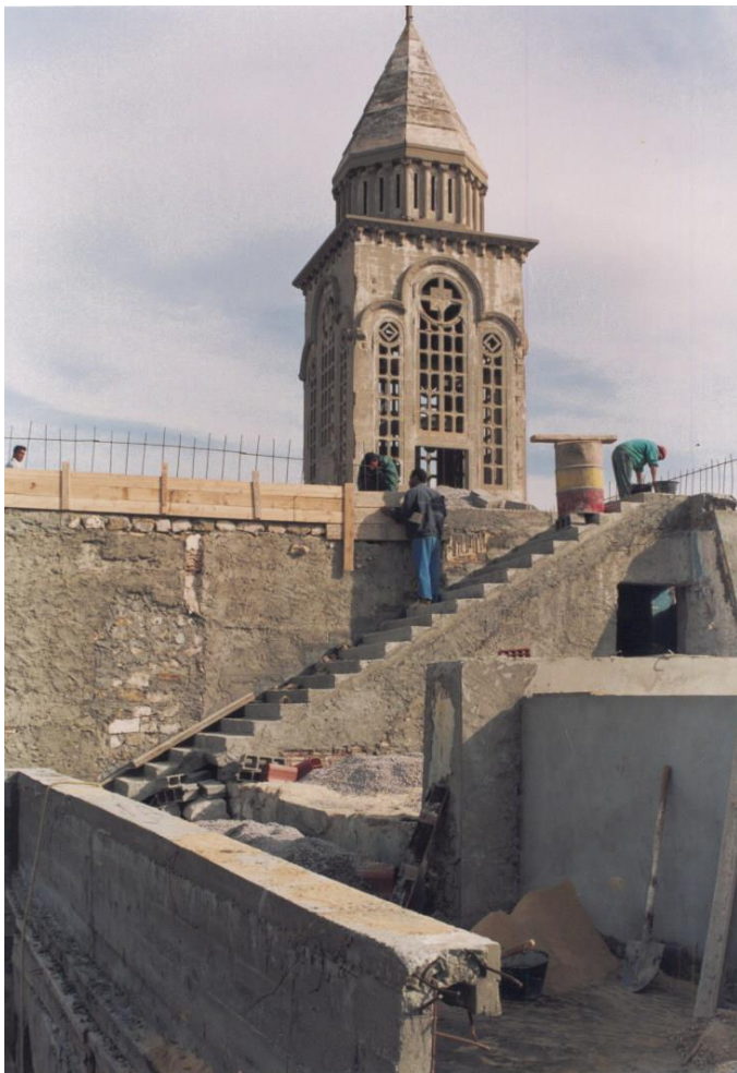
Vue de la terrasse du presbytère et clocher avant restauration
