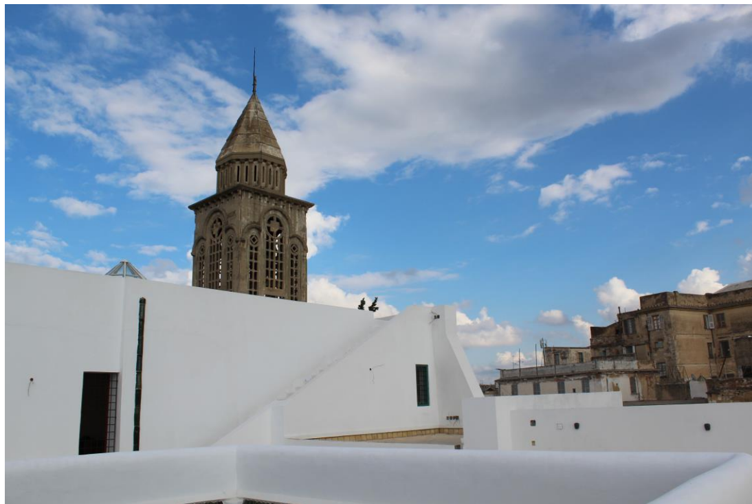
Vue de la terrasse du presbytère et clocher après restauration
