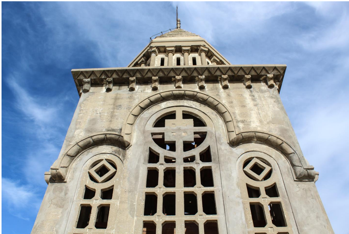
Le clocher de l'église de Sainte Croix après restauration
